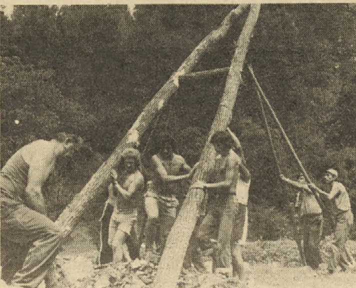
S skupnimi močmi krajanov, brigadirjev, vojakov in elektricarjev iz Tolmina in Kobarida so po skoraj 42 km dolgi trasi postavili okrog tisoč drogov za električno napeljavo. (Foto: Stane Jesenovec)
