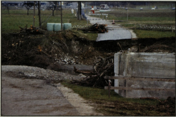
Odstranili konstrukcijo začasnega mostu.
