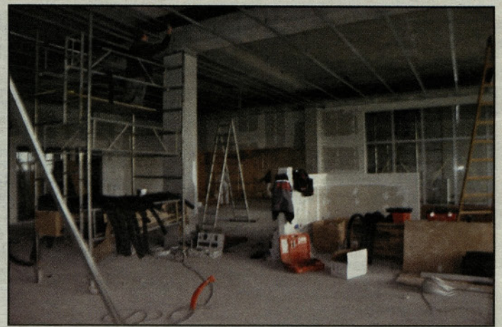
Pospešena izvedba del v kulturnem domu
