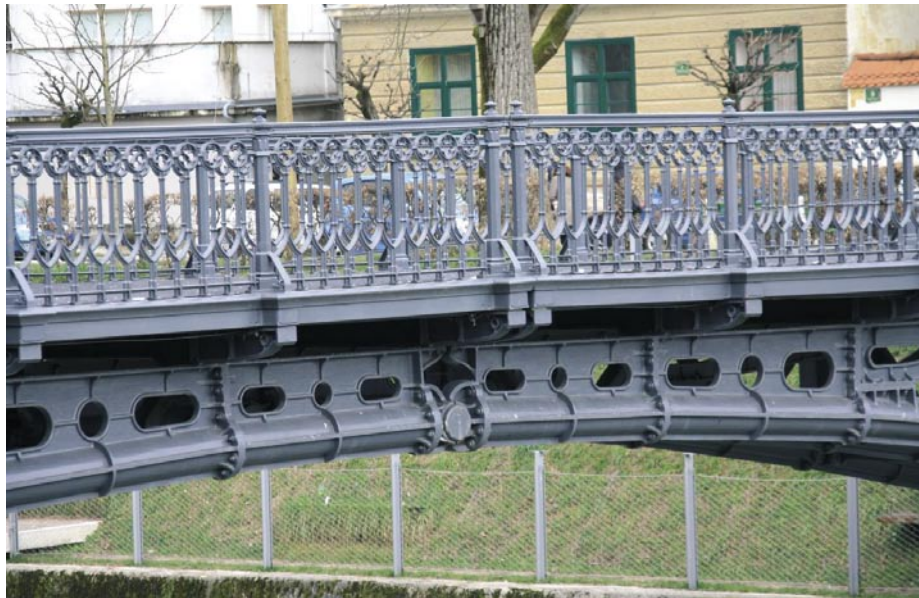
Slika 14 • Gibljivi členek je v sredini ločne konstrukcije mostu (foto: G. Humar)
