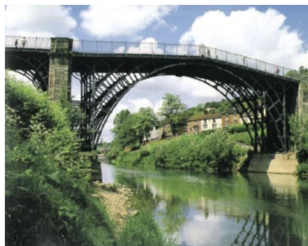
Slika 7 • Litoželezni most v Ironbridgu v Angliji, zgrajen leta 1779 in ki še danes stoji, je bil prvi litoželezni most na svetu. Razpon loka meri 30 m (ECCE, 2009)
