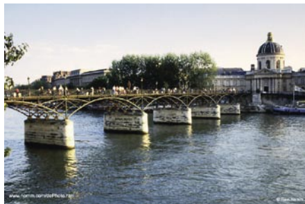
Slika 9 • Pont des Arts v Parizu, prvi litoželezni most v Franciji, zgrajen leta 1804 (vir: Wikipedia)
