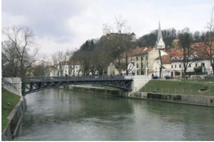
Slika 1 • Hradeckega most na novi lokaciji ob izlivu Gradaščice v Ljubljano (foto: G. Humar)
