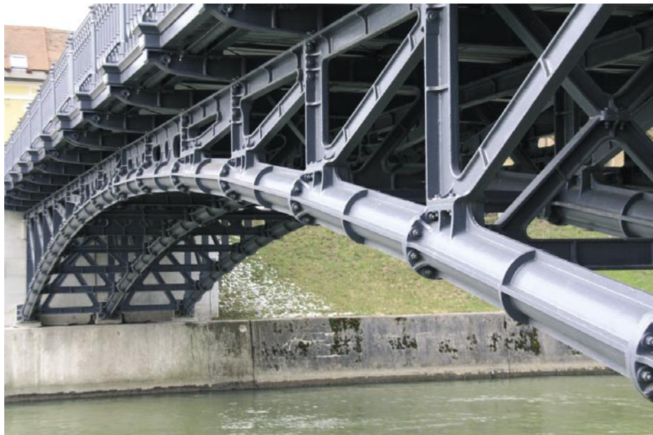
Slika 11 • Hradeckega most – pogled s spodnje strani (foto: G. Humar)
