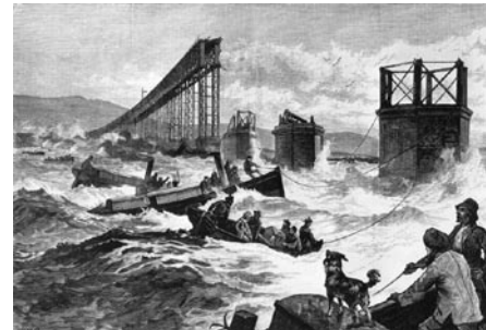
Slika 10 • Med nevihto, ko je veter pihal preko 100 km/h, se je leta 1879 porušil železniški most Tay Bridge v Angliji. V vlaku, ki je padel v globino, je umrlo 75 potnikov
