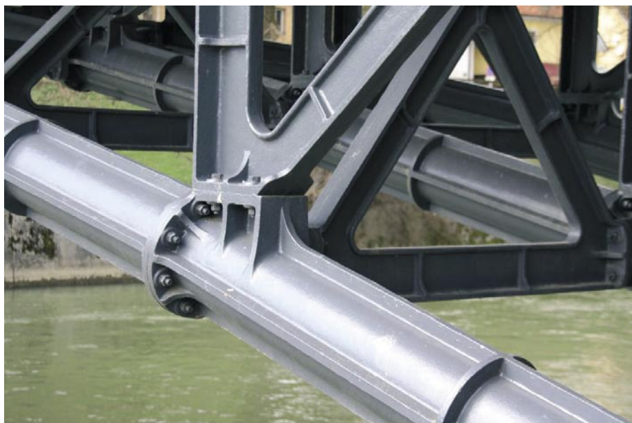
Slika 12 • Detajl vozlišča nad cevnim lokom (foto: G. Humar)
