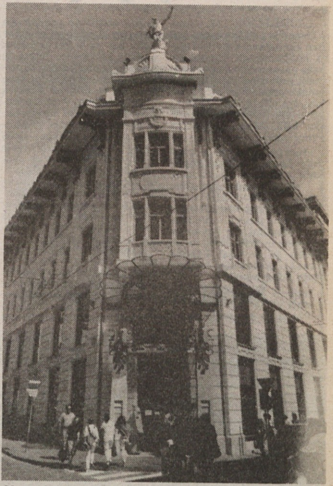
Obnovljena fasada veleblagovnice Centromerkurja v Ljubljani
