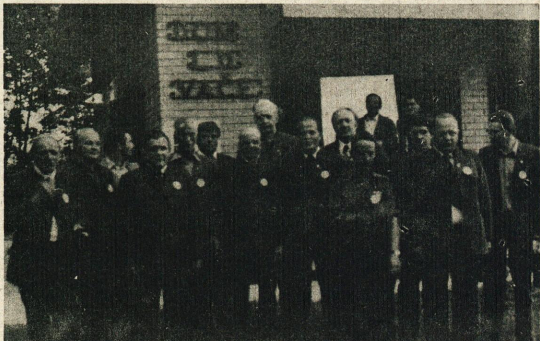
Nov lovski dom na Mačkovcu nad Vačami in člani LD zbrani pred njim ob slavnostni otvoritvi. Dom ima 60 kv. m površine, notri pa je sejna soba, kuhinja, sanitarije in prostor za nočitve. V bližini doma je tudi strelišče za streljanje na glinaste globe in za streljanje z risanico.
