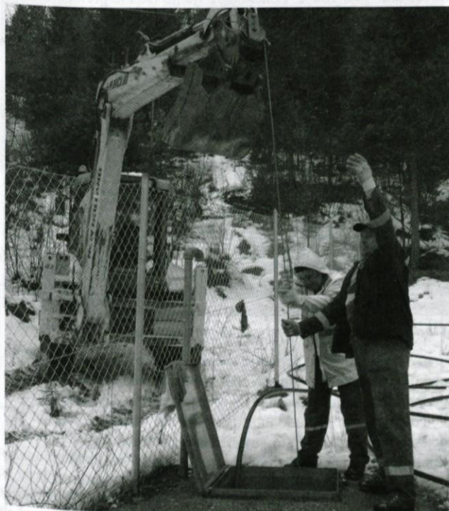
Spušcanje črpalke v globinsko zajetje.
