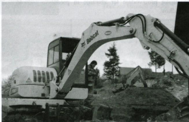
Izkopi za naselje na Tičnici.
