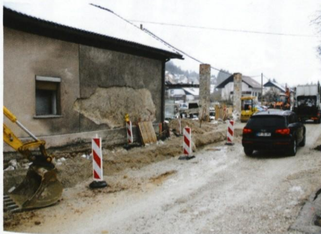
Gneča na gradbišču.
