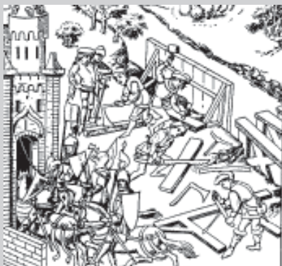
□ Slika 7. Gradnja lesenega mostu čez reko (Kühnel, 1986: 80)
