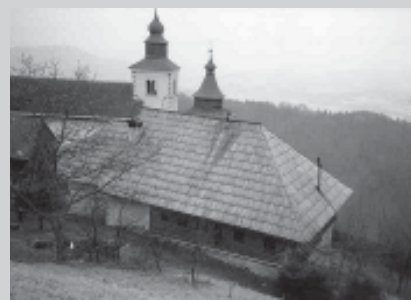
□ Slika 4. Lesena kritina (skodle) na Sv. Primožu nad Kamnikom. Lesena kritina se je do danes ohranila le tam, kjer so bili za to močni razlogi (tradicija, cena, majhna možnost širitve požara).
