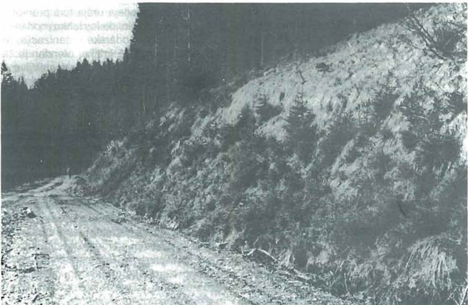
Naravno zaraščanje odkopne brežine na gozdni cesti le nekaj let po gradnji (foto: mag. A. Dobre)
