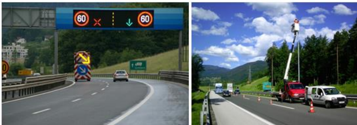
Slika 6-28: Dela na prehitevalnem pasu Figure 6-28: Road works on left lane
