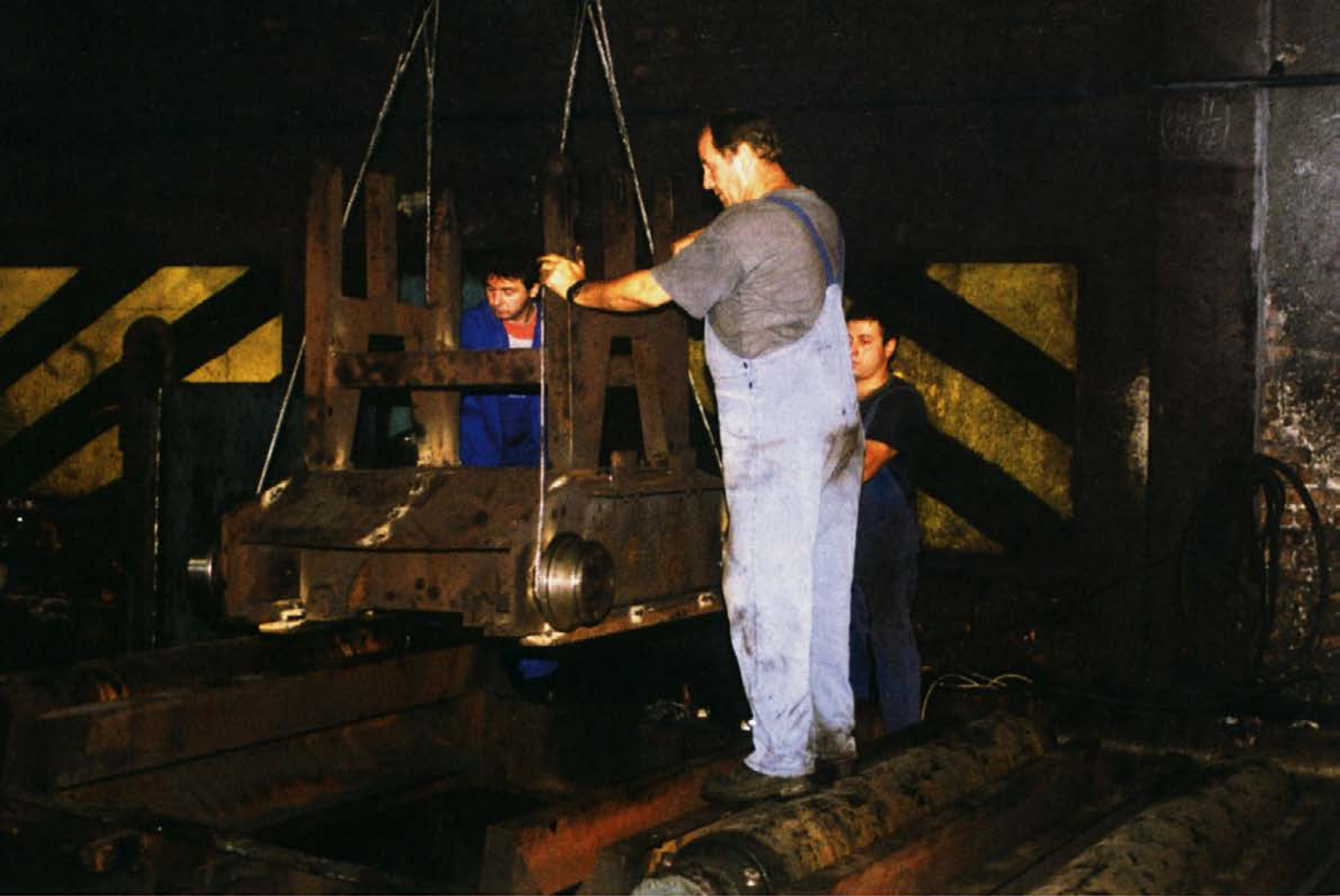
Montaža manipulatorja na prvi dvizni mizi
