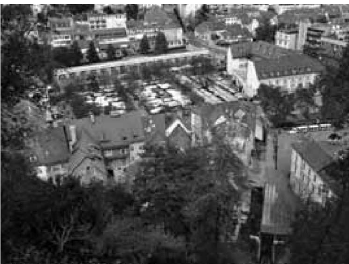
Pogled z gradu: skozi topografijo in morfologijo jasno berljiva geneza nastanka Vodnikovega trga: poteza nekdanjega srednjeveškega obzidja ob današnji vzpenjači, Mahrovi hiši, tja do Plečnikove kolonade.
