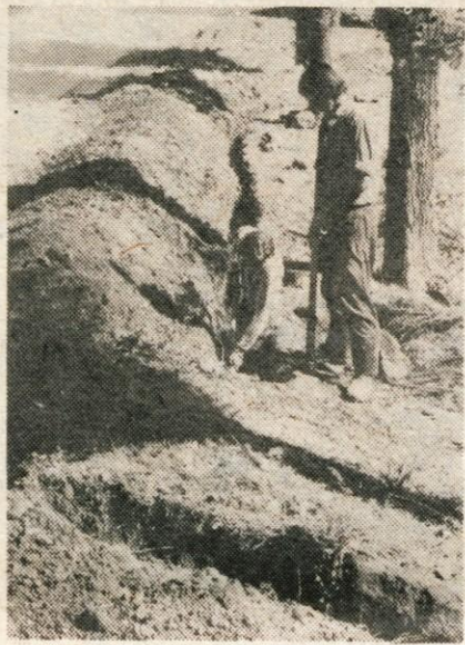
Delavci podjetja Tegrad iz Ljublja- ne polagajo v Finžgarjevi ulici v Lescah kable za novo telefonsko na- peljavo. Število telefonskih naroč- nikov v tem delu Lesc se je povečalo, sedanja napeljava pa je za večje število telefonskih priključkov pre- šibka. — B. B.
