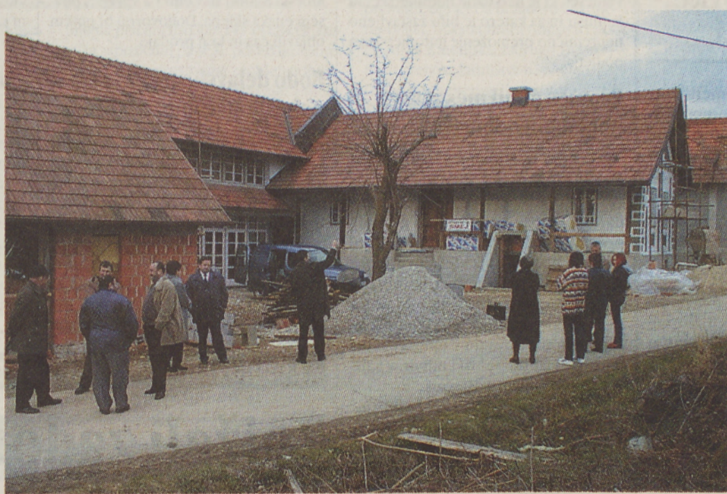
Podrobnejšo predstavitev Španove domačije za svetnike in novinarje je opravil projektant in nadzornik ureditve Daniel Smeč. Gradbena dela opravlja podjetje Gradbeništvo Smej iz Odranec. Foto: T. K.
