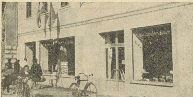
Že preurejena poslovalnica PE Gradišče v Trebnjem
