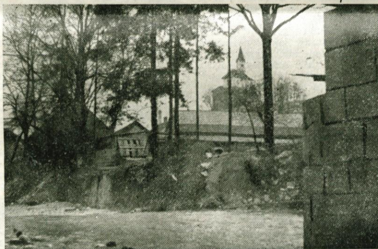
Nič kaj privlačen ni pogled na desni breg Bistrice pri obratu »Novogradnje«
