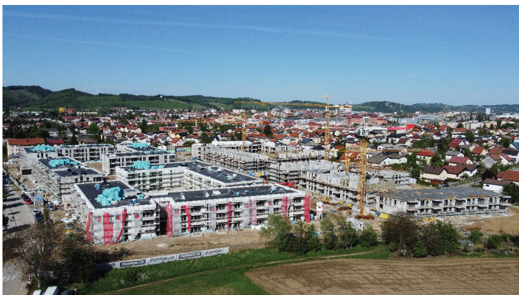
Slika 2 • Obrtniška dela faze 1 in gradbena dela faze 2, maj 2021.
