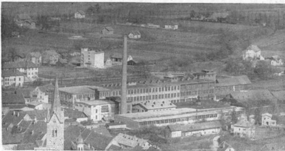
Slov. Konjice — v ospredju usnjarski kombinat Konus z novozgrajenim obratom za umetno usnje
