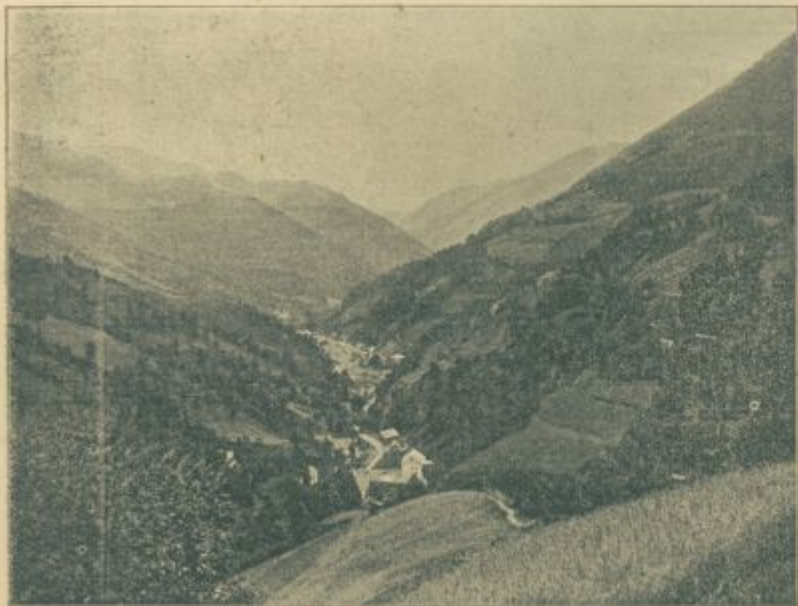
Z bohinske železnice: Podbrdo s Petrovega brda.
