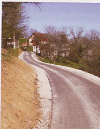
Cesta Paridol-Zapuže ima novo asfaltno prevleko.
