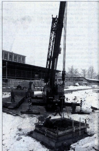
Z ogromnim žerjavom so svetišče, pod katerega so vili betonsko ploščo, dvignili iz zemlje ...
