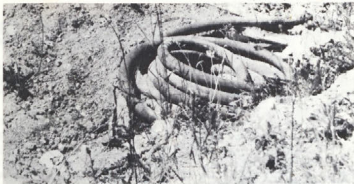
Brez strahu! Ni kača. „Le“ gumijasta cev – brez lastnika. Tako poležava na gradbišču pri energetiki. (Foto L. Marolt).
