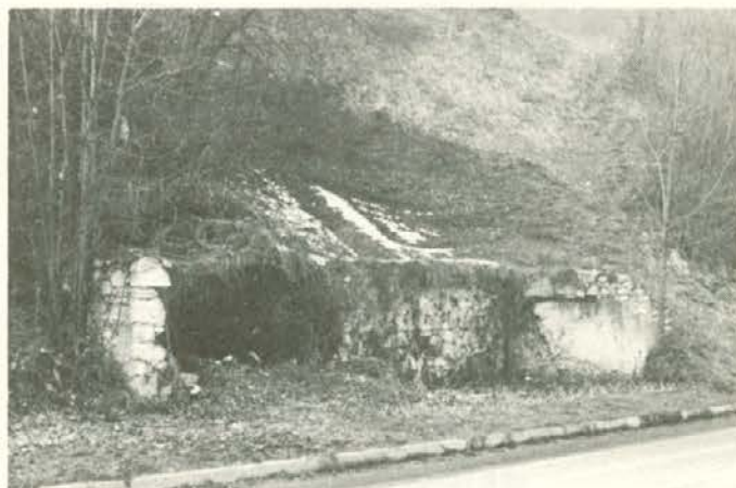
Opušeni temelji Mušeniških fužin, foto Matevž Čarf
