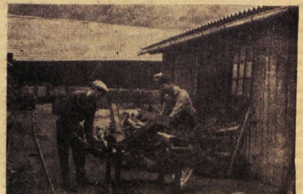
Popravilo jamskih stojk
