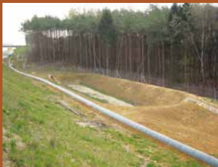
Varovalne ograje za dvoživke na avtocestnem odseku Cogetinci-Vučja vas leta 2008. (foto: Katica Pobljšaj)
