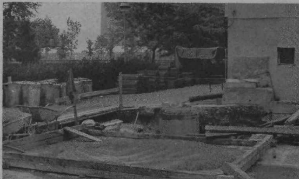
V Savskem naselju letos v 6 blokih napeljujejo daljinsko ogrevanje. Stanovanjska skupnost je zagotovila sredstva, izvajalci pa bodo zaključili dela v pogodbenem roku. Tako bodo dela predvidoma končana v blokih Matjaževa 1-5, Luize Pesjakove 13-19, Fabjanjeva 17-23 in 31-35 do srede oktobra meseca. Nekaj kasneje so začeli z delom v blokih Majaronova 2-6 in Fabjanjeva 2-15, kjer bo centralna kurjava začela greti predvidoma sredi novembra. Vsa zunanja dela potekajo po planu in bodo zaključena do srede oktobra, tako da bo centralna kurjava kljub vsem težavam kmalu nared.
