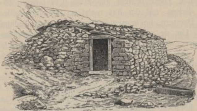
Fig. 8. Sennhütte in Réši Wukótscheß, westlich von Gussinje.
