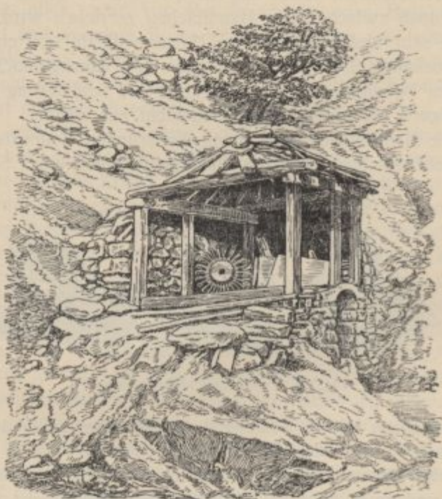
Fig. 39. Turbinenmühle in Brebúla.
