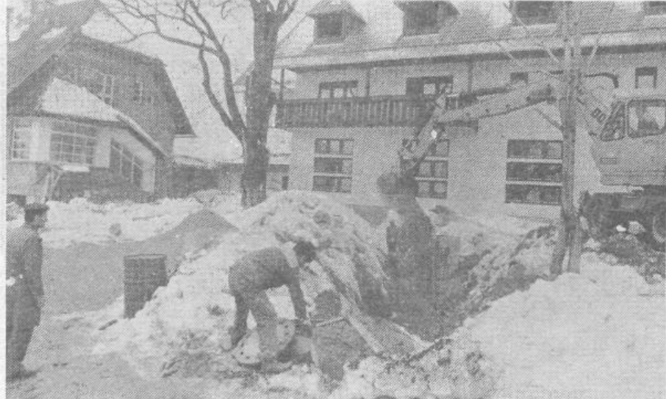
Gradnja na Rakitni se bliža koncu
