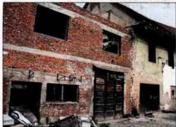
Nekdanji poslovni objekt ob Mošeniku bo občina porušila.
