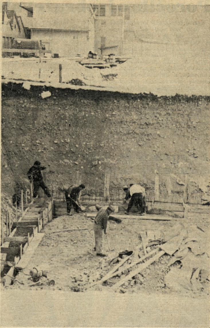
Gradnja v obratu I napreduje po planu
