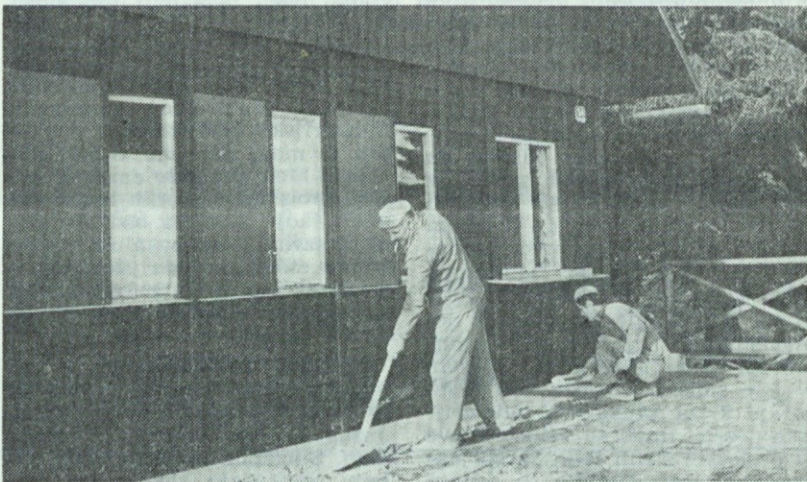
Teraso ob zgornjem domu, ki je vedno puščala, smo izolirali
