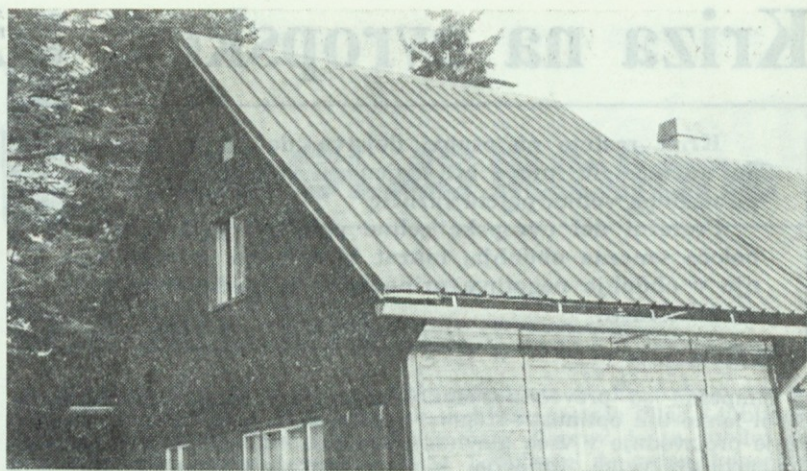
Stari, zgornji dom na Soriški planini je dobil prepotrebno novo streho iz plastificirane pločevine. Upajmo, da bo prav tako trpežna, kot je lepa (Foto: E. Lampič)
