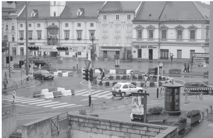
Sl. 3. Montažno trikrako, enopasovno krožišče na Koroški ulici v Mariboru Fig. 3. Montage three-armed, one-lane roundabout on Koroška Street in Maribor
