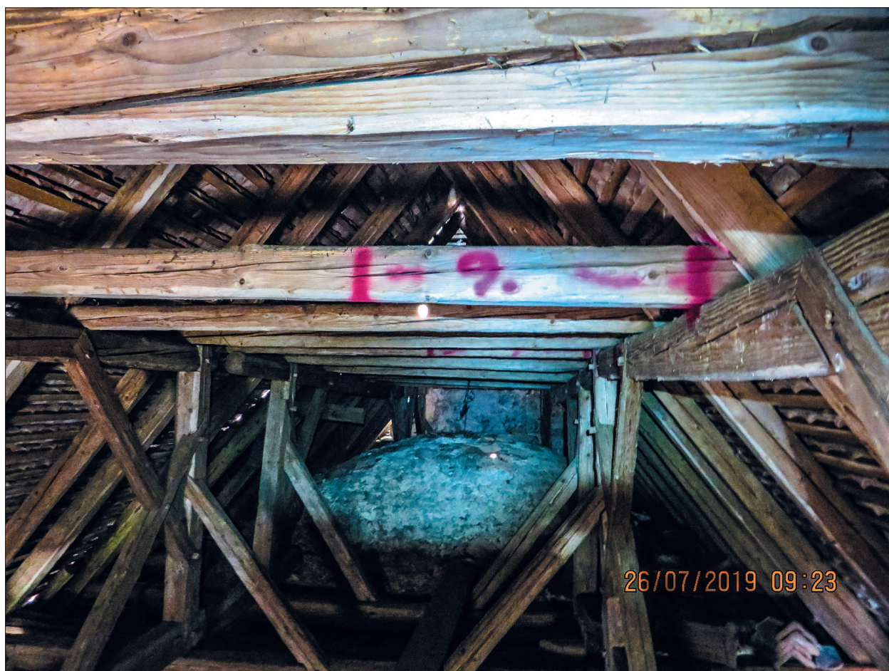
Slika 1. Del stare strešne konstrukcije cerkve sv. Barbare v vasi Ravnik pri Hotedršici.
