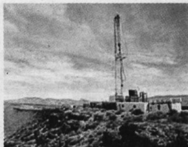
Z vrtnjem nekaj 100 m globoko bodo prišli do vzorcev kamnine, v katerih bodo lahko izmerili količino vode. Tako bodo ugotovili, kakšne so poti vode skozi kamnino na območju, kjer bi lahko bilo odlagališče..
