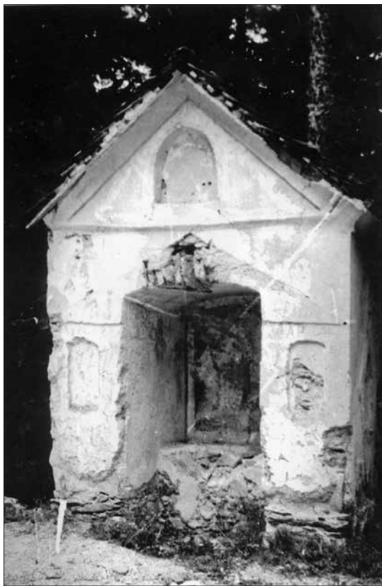
Jezdna postaja na Požarnikovem, fotografiral sem jo leta 1978. Zunanji videz spominja na kapelico, sedaj je tudi urejena kot kapelica.
