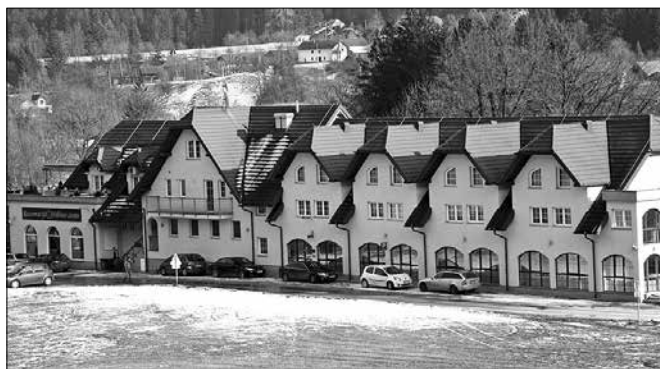
Minula dva meseca so pri hotelu izkoristili za temeljita vzdrževalna in obnovitvena dela. (Foto: Jože Miklavc)
