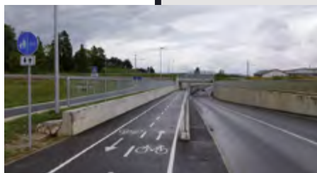
Na novo urejen podhod in cestna infrastruktura.
