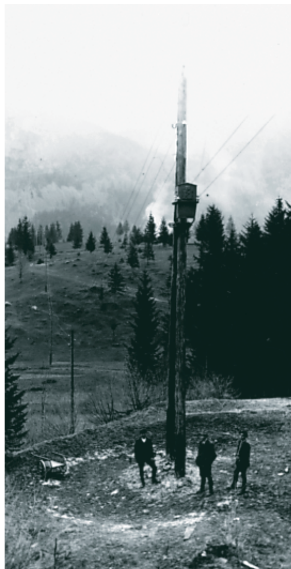
Transformatorska postaja KDE na drogu blizu vasi Kamnje (1923), črno-beli motiv na stekleno ploščo F. Solarja, hrani Marjan Šolar, Bled.
