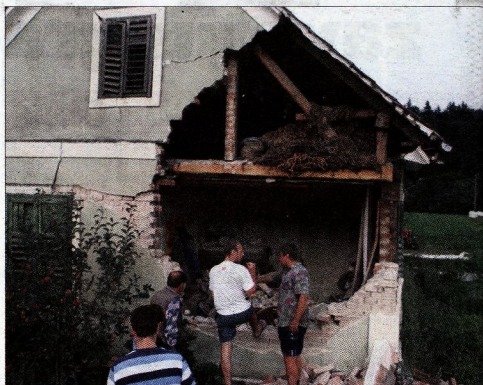
Avto je zrušil cel vogal hiše. Foto: SHERPA
