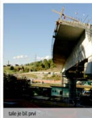
narivanje prekladne konstrukcije: 6. delov
