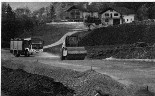
Zaradi gradnje ceste med Sotesko in Gorenjem je cesta zaprta, obvoz pa poteka skozi Šmartno ob Paki (foto: Jože Miklavc)
