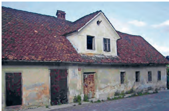
Stavba Občine Dobrepolje na desni strani in prve posojilnice na Kranjskem na levi strani slike. 5
