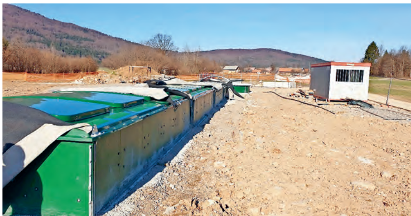
Slika 5: Gradnja osrednje ČN Bruhanja vas.
