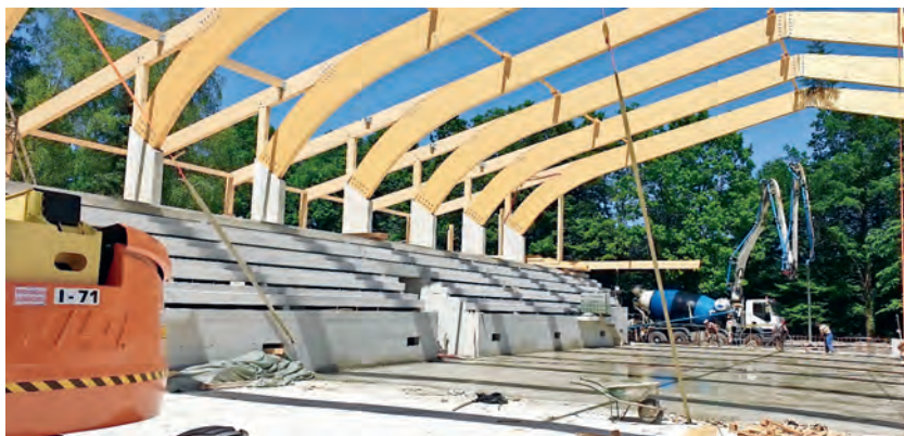
Slika 4: Gradnja večnamenske, »skoraj nič energijske« športne dvorane.
