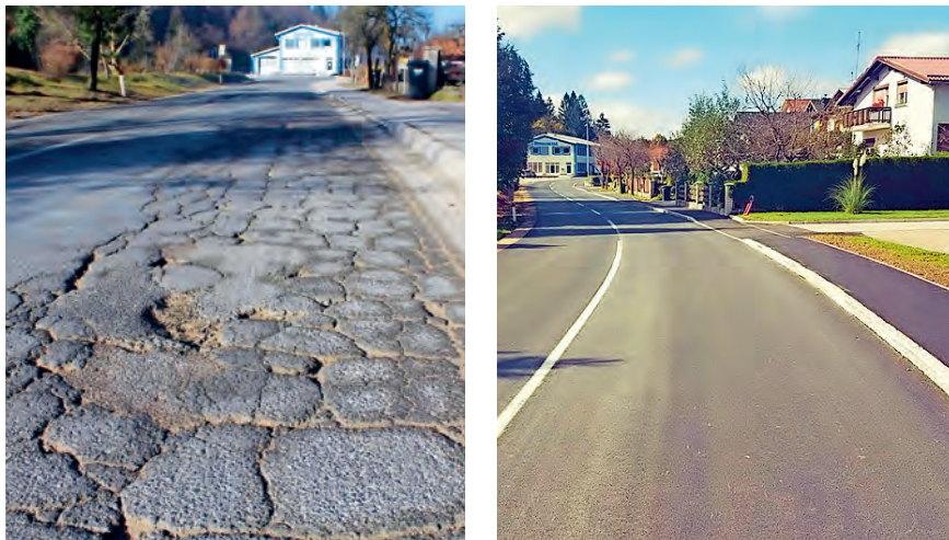
Cesta v Predstrugah pred in po obnovi.
