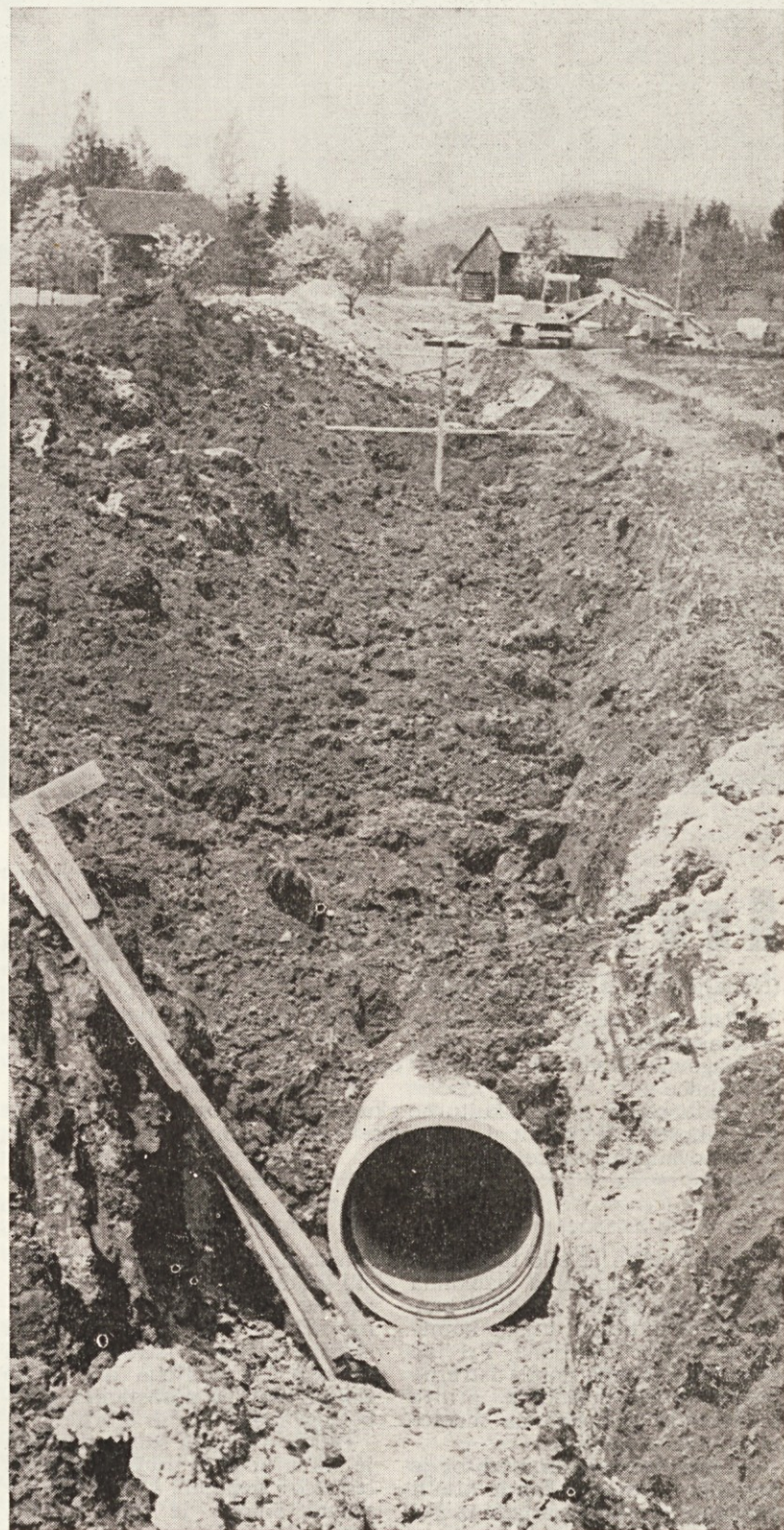
Urejanje kanalizacije s Peščanka v Cerknici
