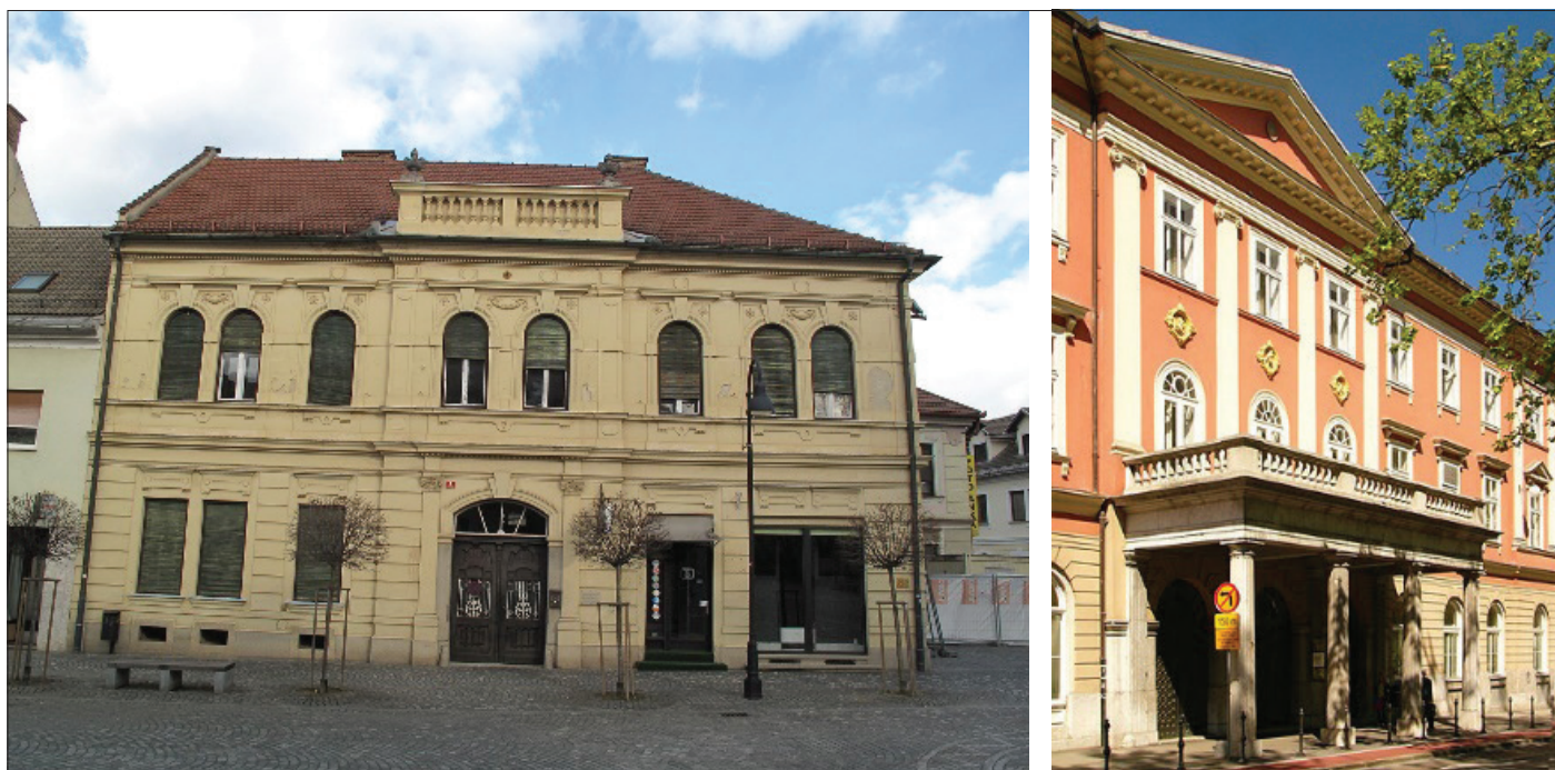
Slika 2 • Železnikarjeva hiša v Slovenj Gradcu (levo) (Koroški pokrajinski muzej, 2020) in Kazina v Ljubljani (desno) (Arhitekturni vodnik, 2020).
