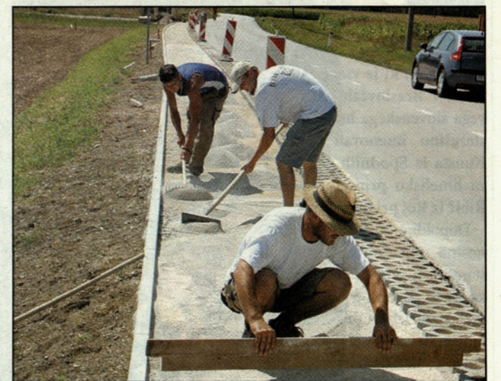
Pri gradnji prvega dela pločnika v Rakovljah
