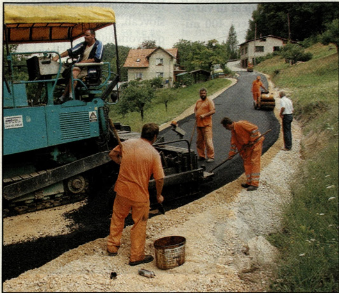
Preplastitev ceste v Zabukovici
