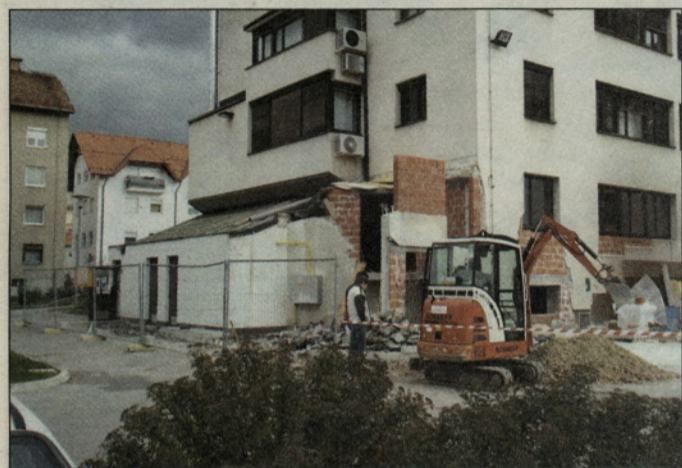
Nov vhod v Upravno enoto bo s parkirišča za občinsko stavbo.
