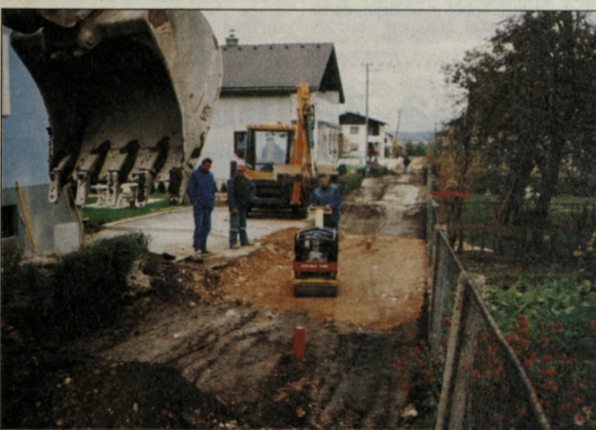
V teh dneh se zaključujejo dela v eni izmed ulic v Dolenji vasi.
