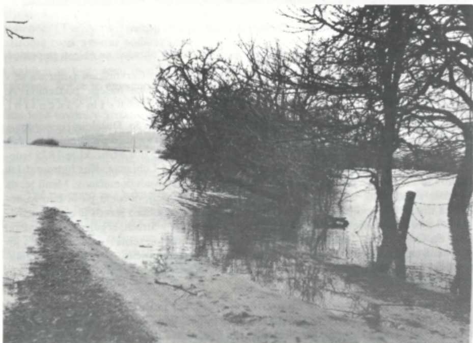
Sl. 7. Lokalno cesto med Gorenjim Jezerom in Lazami visoka voda redno zalije
