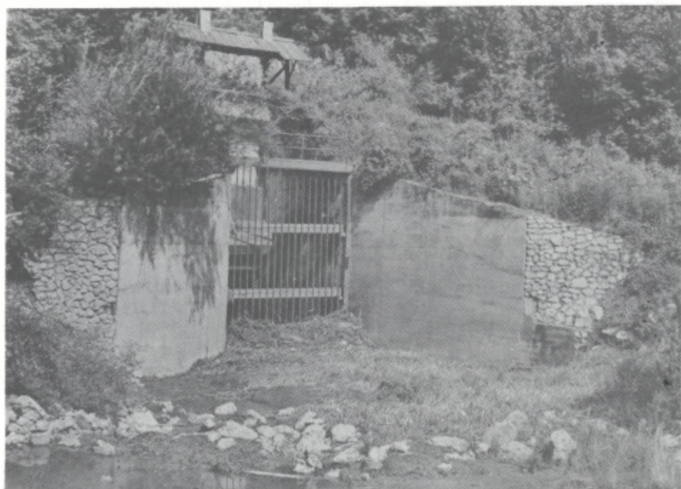
Sl. 9. Mreža in zapornica pred tunelom v Veliko Karlovico, zgrajeni 1969 v okviru projekta »Stalna ojezeritev Cerknškega jezera«
