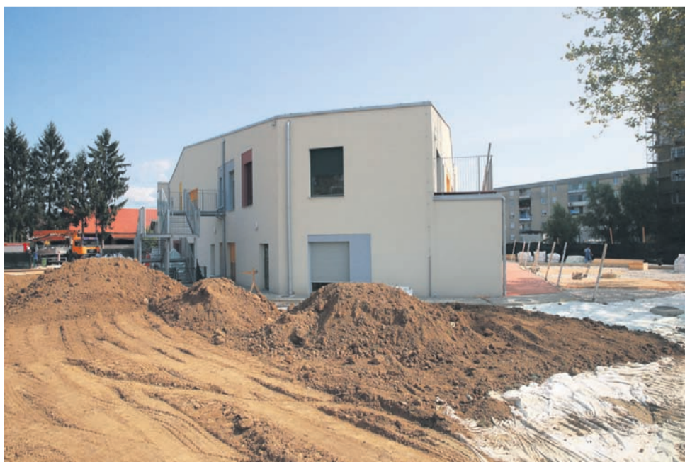
Dela pri obnovi zemljine v vrtcu Hudinja gredo po načrtih.
