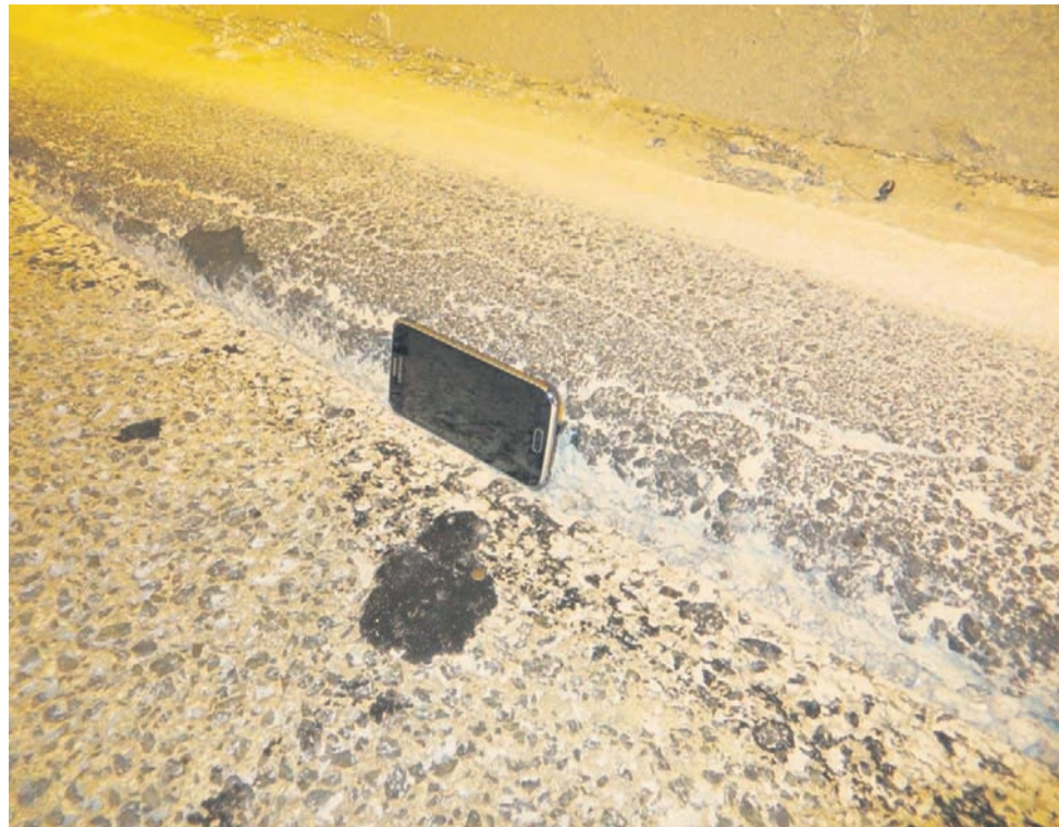
Primerjava s širino mobilnega telefona. Šlo je za nevarno posedanje, pravijo pri Darsu.
