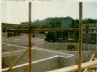
Čistilna naprava Sežana
