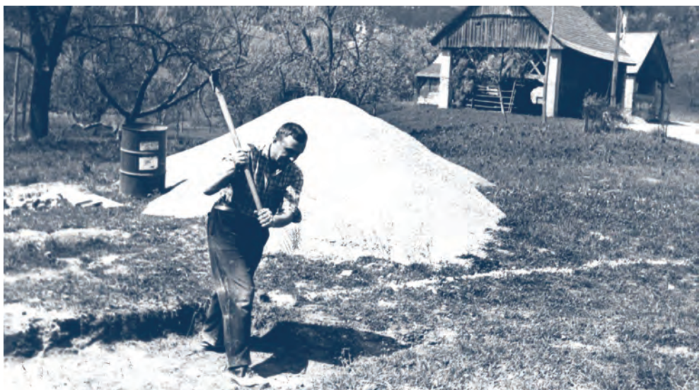
Ivan – začetek gradnje nove hiše; leta 1970.
