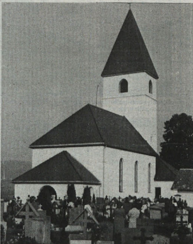
Obnovljena farna cerkev
