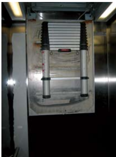
Spuščena loputa, ki je v stropu kabine, z zložljivo lestvijo.
