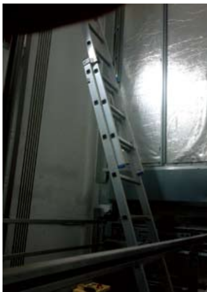
Lestev, postavljena na strehi kabine, za dostop do jaškovnih vrat.
